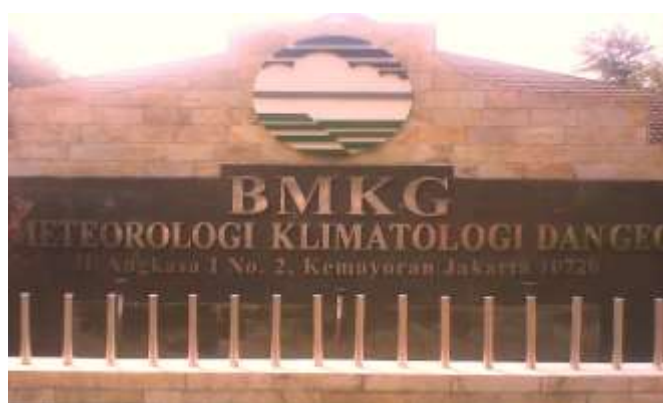
Gambar 2.1 Gedung BMKG Tampak Depan
